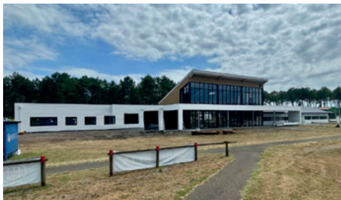
L'avancée des travaux du stand fédéral d'Ychoux. Photo@FFBT
