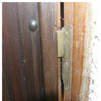
**Profil de recouvrement porte ouverte vu de l'extérieur du local.** Ce profilé de tôle de 2,5 mm pliée en atelier, recouvre toute la hauteur de la porte côté paumelles. *On aperçoit ici une des paumelles de la porte.*
