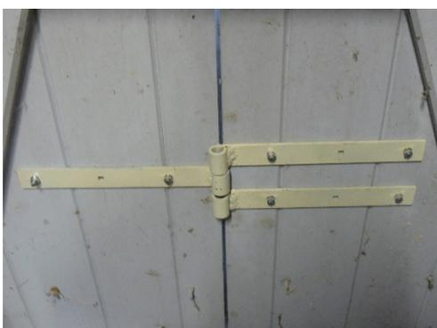
**Pose des pentures boulonnées** (ici sans le verrouillage, une sur 1 battant de volet, et deux sur l'autre) **côté intérieur des volets**. Les têtes rondes de vis sont à l'extérieur des volets. **Le point de verrouillage** est à la jonction d'ouverture entre les deux battants
