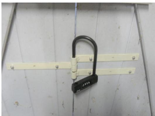
**Pose :** Le plus possible au milieu de la hauteur des battants de volet. Pour des volets de grande hauteur (devant une porte fenêtre par exemple, on peut poser cette installation en deux endroits à 60 cm du haut et du bas des battants par exemple).
