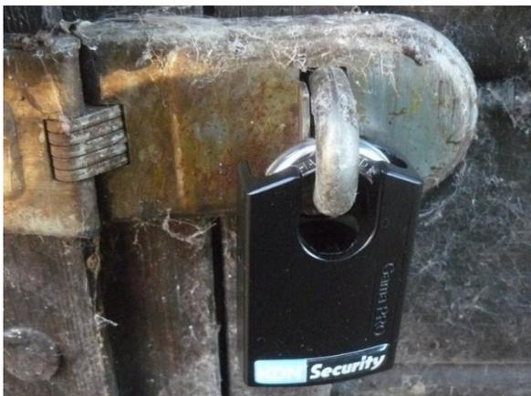
*Sur cette porte de grange, on voit un cadenas où le passage autour de l'anse cimentée de 10 mm de diamètre est limité, empêchant d'y glisser un gros levier de forçage. L'auberon du morillon lui-même cimenté, est d'un diamètre un peu supérieur à celui de l'anse du cadenas, ce qui confère à l'ensemble une résistance certaine.*
