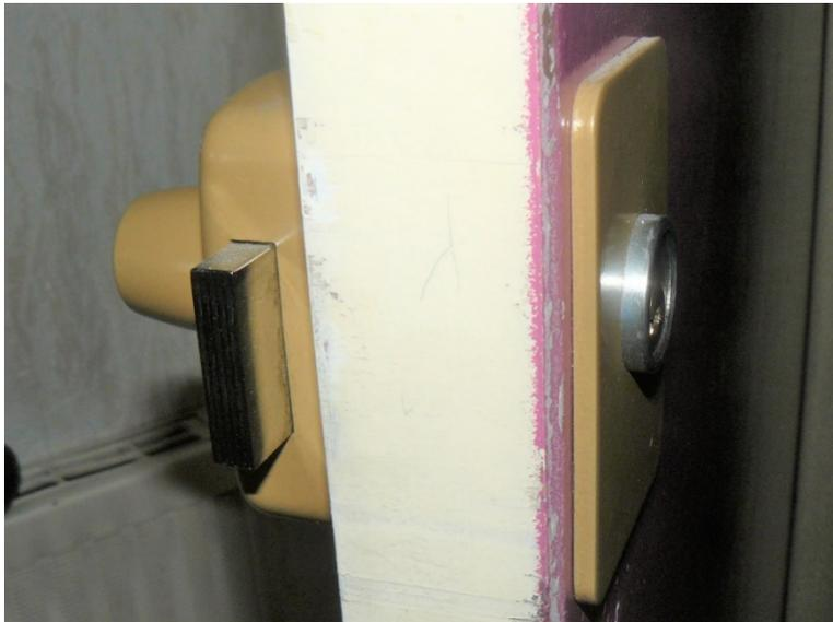
Il est souhaitable que la plaque extérieure de l'entrée moisée, soit en acier et si possible trempé pour empêcher au maximum le perçage. **Une cuirasse en acier cémenté comme c'est le cas ici, peut également envelopper le canon du verrou pour empêcher au maximum son perçage et son arrachement.**
