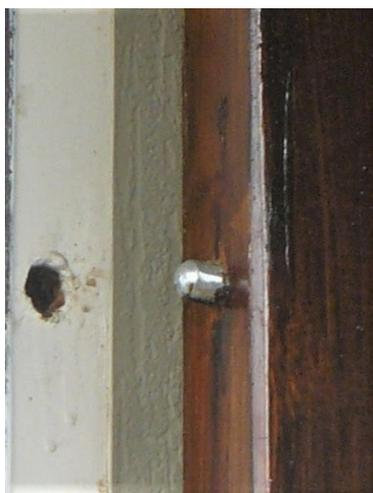
Téton de renfort fixé sur le chant de la porte (ici ouverte) côté paumelle, et qui rentre dans sa gâche percée et fixée dans la feuillure de l'huisserie à la fermeture de la porte.
