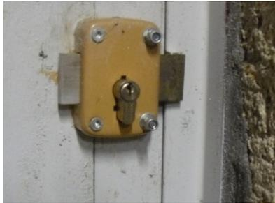
**En revanche, il faudra fixer le verrou (ou la serrure) avec des boulons à tête ronde, à vis de 6 mm de diamètre traversant la porte pleine (dans ce cas mettre une rondelle derrière l'écrou pour en augmenter la surface d'appui sur le coffre du verrou) ou avec une entrée moisée (obligatoire si la porte est**
