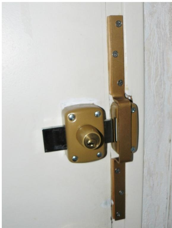
Fixer le verrou avec des **vis de 6 mm de diamètre** (*avant-trou dans le bois de 3 mm et graissage des vis*), et rentrant de 35 mm dans la porte si elle fait 40 mm d'épaisseur (*quitte à agrandir un peu les trous de passage des vis du verrou s'ils sont trop petits*). Eviter si possible que le canon du verrou (*ou de la serrure*) ne dépasse de la surface de la porte, pour éviter le risque d'arrachement.
