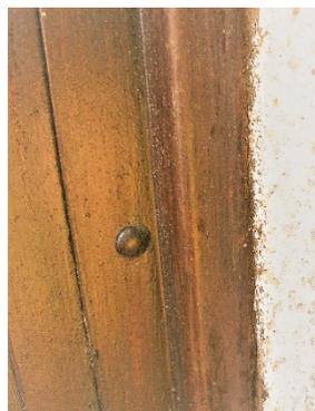
**Profil de recouvrement porte fermée vu de l'extérieur du local.** Il est alors impossible de passer le bec d'un levier entre la porte et l'hubriserie côté paumelles, et la fixation sur toute la hauteur de la porte avec des boulons, rend l'ensemble très solide.
